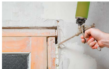
Posizionamento rapido di controtelai.
