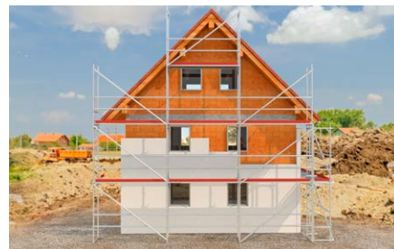
Fissaggio di pannelli di isolamento a cappotto.
