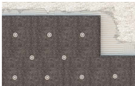
Fissaggio di pannelli isolanti.
