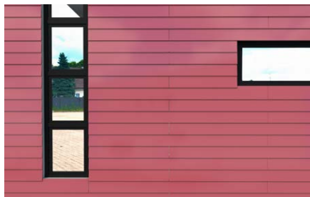
Sigillatura di serramenti.
