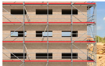
Ponteggio per facciata.
