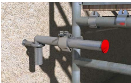
Fissaggio al ponteggio.
