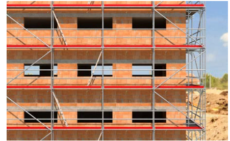
Ponteggio per facciata.
