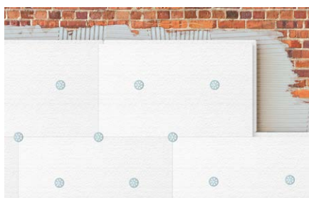
Pannelli in schiuma rigida di polistirene su mattoni pieni.
