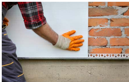
Incollaggio di lastre di cartongesso.
