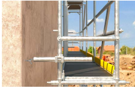
Fissaggio al ponteggio.
