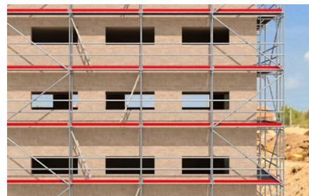
Ponteggio per facciata.
