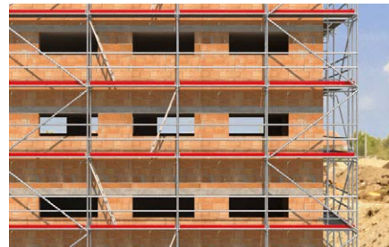
Ponteggi di facciata.
