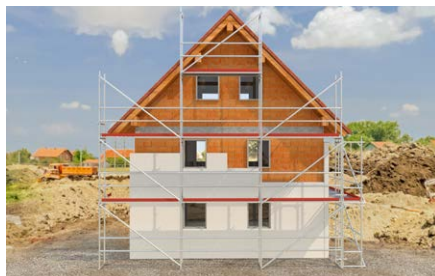
Incollaggio di pannelli isolanti per sistemi ETICS.
