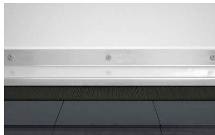
Fissaggio di scossaline in lamiera.
