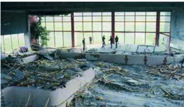
Nel 1985 a Uster (Svizzera), il controsoffitto sospeso in calcestruzzo di una piscina coperta è crollato. Gli elementi di sospensione del controsoffitto, in acciaio inossidabile, non mostravano alcun difetto esterno, ma in alcuni casi internamente erano completamente distrutti dalla corrosione sotto tensione.
