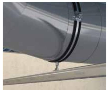
Strutture di supporto per sistemi di ventilazione.
