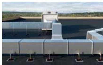
Strutture di supporto per sistemi di ventilazione.
