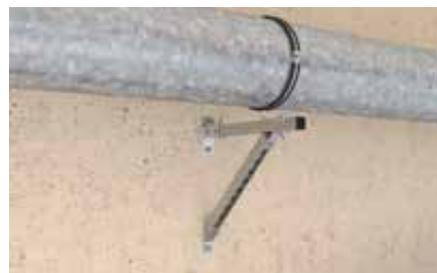
Strutture di supporto per sistemi di ventilazione.
