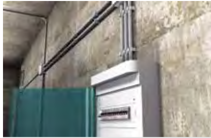
Fissaggio tubi in PVC
