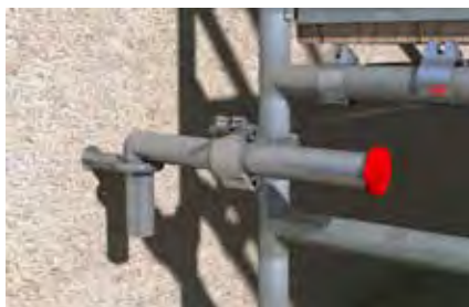
Fissaggio al ponteggio
