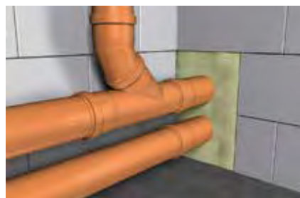
Riempimento di attraversamenti di tubazioni
