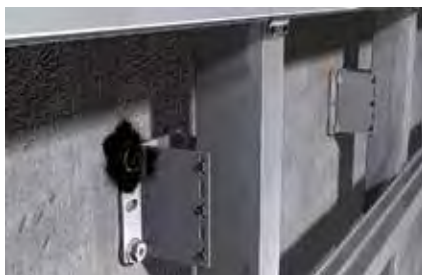
Sigillatura della testa delle viti
