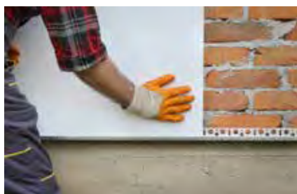
Incollaggio di lastre di cartongesso.
