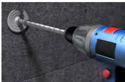
Installazione su diversi spessori di pannello.
