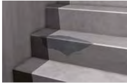
Ricostruzione di angoli e bordi
