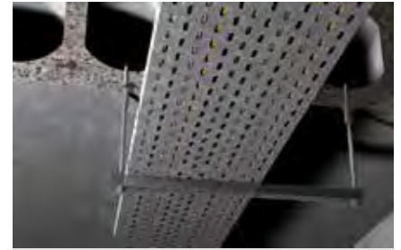
Solai in calcestruzzo alveolare precompresso
