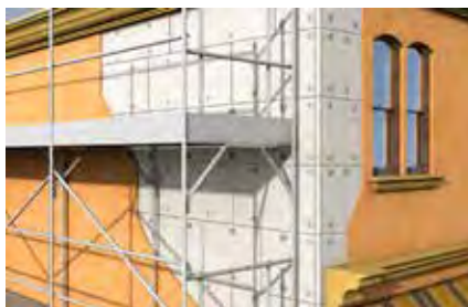
Fissaggio di pannelli isolanti
