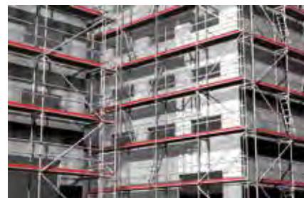
Ponteggio per facciata
