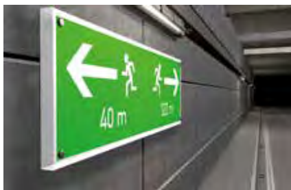
Segnali di uscita di emergenza in galleria
