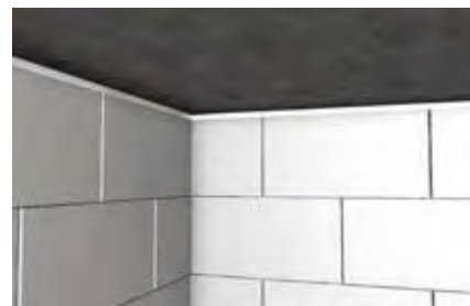
Giunti lineari fra parete e solaio.
