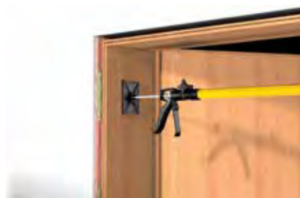
Schiumatura di telai di porte
