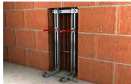
Dettaglio: installazione sistema L Plus
