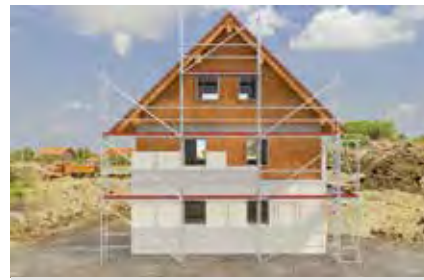
Fissaggio di pannelli di isolamento a cappotto.
