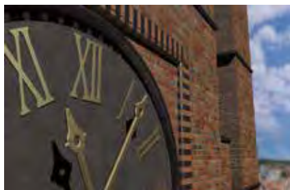
Risanamento murature faccia vista
