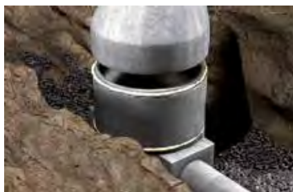
Sigillatura anelli di pozzetti di calcestruzzo
