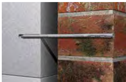
Risanamento murature faccia vista
