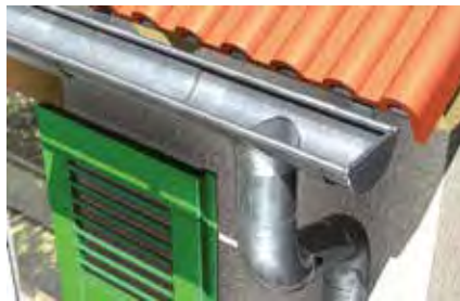
Sigillatura di grondaie
