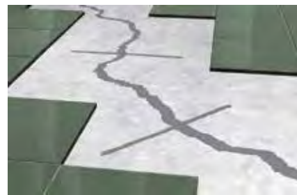
Sigillatura di fessure
