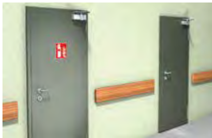
Pannelli di rivestimento pareti
