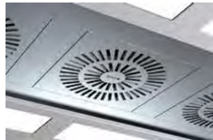
Sigillatura di condotti di ventilazione
