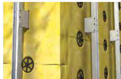
Materiali di isolamento in facciate retro-ventilate
