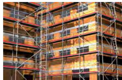
Ponteggio per facciata
