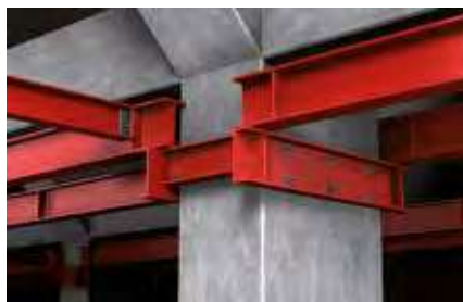
Strutture in acciaio
