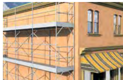
Ponteggi di facciata
