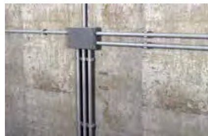
Fissaggio tubi in PVC
