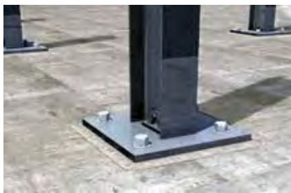
Malta di livellamento per piastre di base
